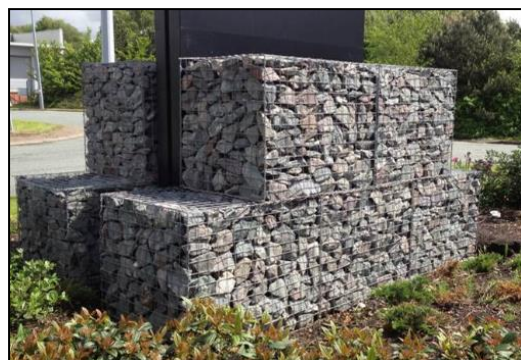
Figure 16 : Exemple de muret en gabion (Source : TCS Geotechnics)
