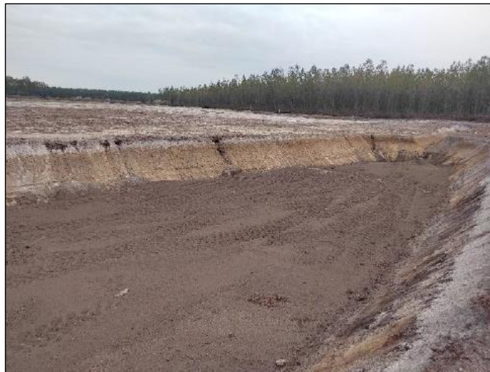
Figure 39 : Secteur en travaux (Source : ETEN Environnement)
