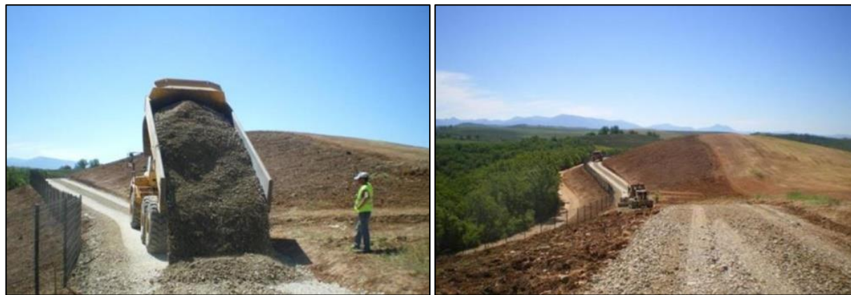
Figure 18 : Illustrations de la préparation du site (Source : MELVAN)
